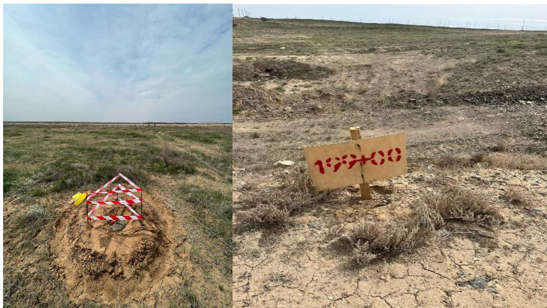
Рис. 1. Установка специальных планово-высотных реперов
